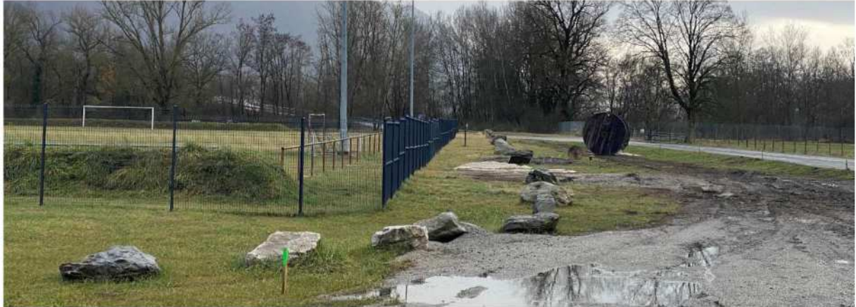
Photo de la clôture de 2 m sécurisant les utilisateurs du stade
